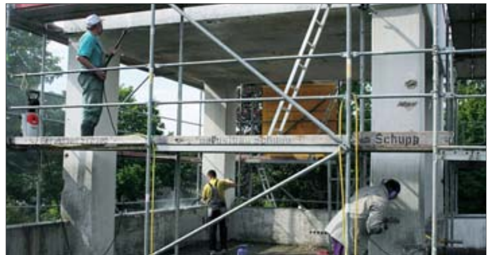
Dank der Helfer aus der Gemeinde konnte bei der Sanierung des Glockenturms gespart werden.
