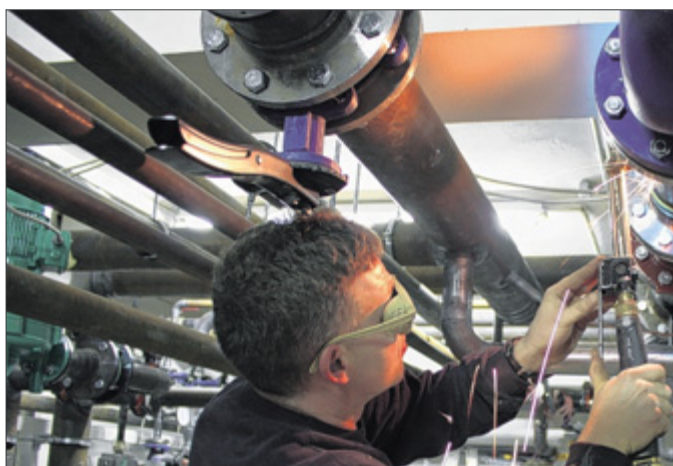
Derzeit wird im Schulzentrum auf dem Rassberg tüchtig montiert und geschweißt: Eine neue Heizzentrale soll bald für umweltfreundliche Wärme durch Holzpellets sorgen. Foto: dibi
