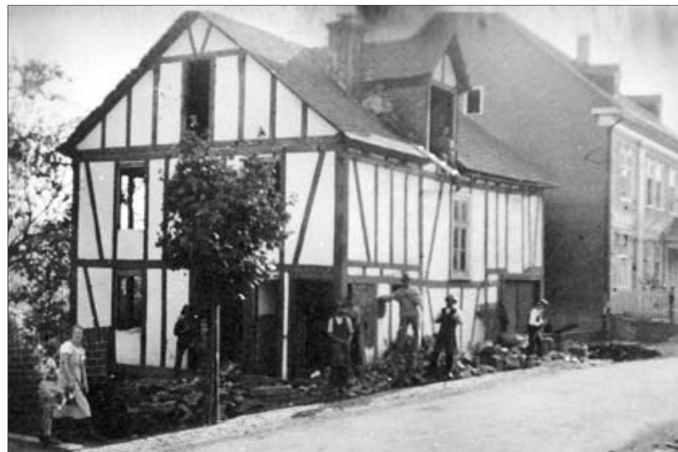
Dieses Haus der ev. Gemeinschaft an der Ecke Wildener Straße/Kölner Straße war auch die erste Heimstatt des CVJM Salchendorf. Foto: CVJM
