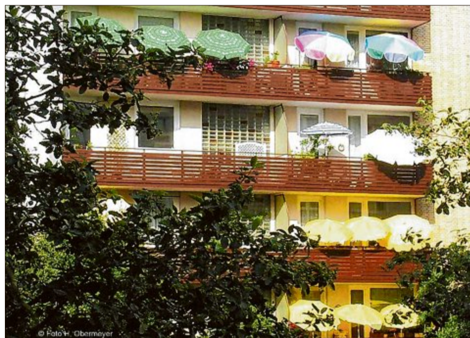
Auf dem Balkon verschafft ein geöffneter Sonnenschirm den Fensterflächen Schatten. Foto: Hermann Obermeyer
