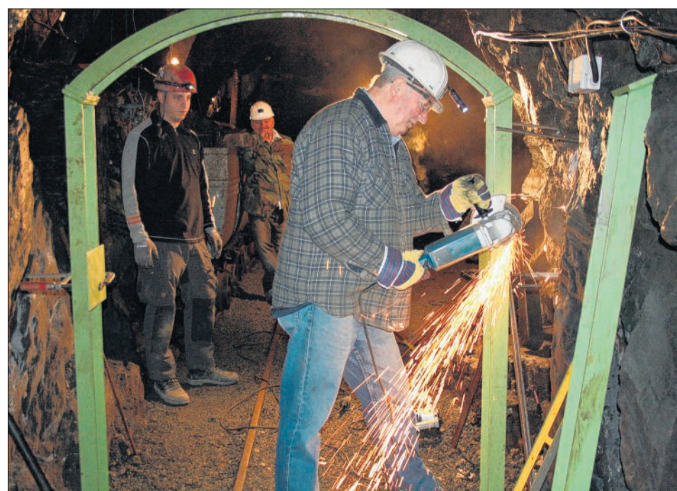
Dieter Prinz schleift die eisernen Bögen ein, dahinter Sascha Greb und Eberhard Ermet.
