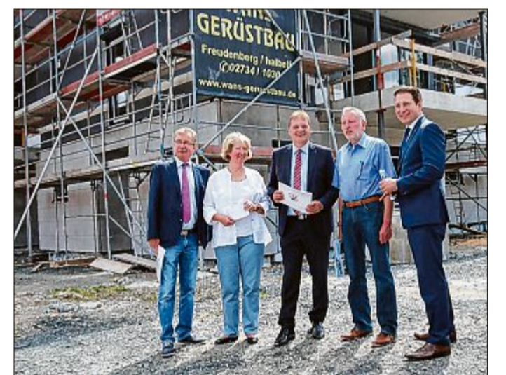
Andreas Weber und Annemarie Bender vom DRK-Kreisverband, Frank Podelh von der DRK-Stiftung und Bernd-Wilbert Müller vom DRK-Ortsverein begutachteten zusammen mit Bürgermeister Bernhard Baumann den Baufortschritt der Tagespflege. Foto: DRK-Stiftung
